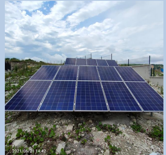
GÜNEŞ ENERJİSİ SANTRALİ UYGULAMA SAHASI
